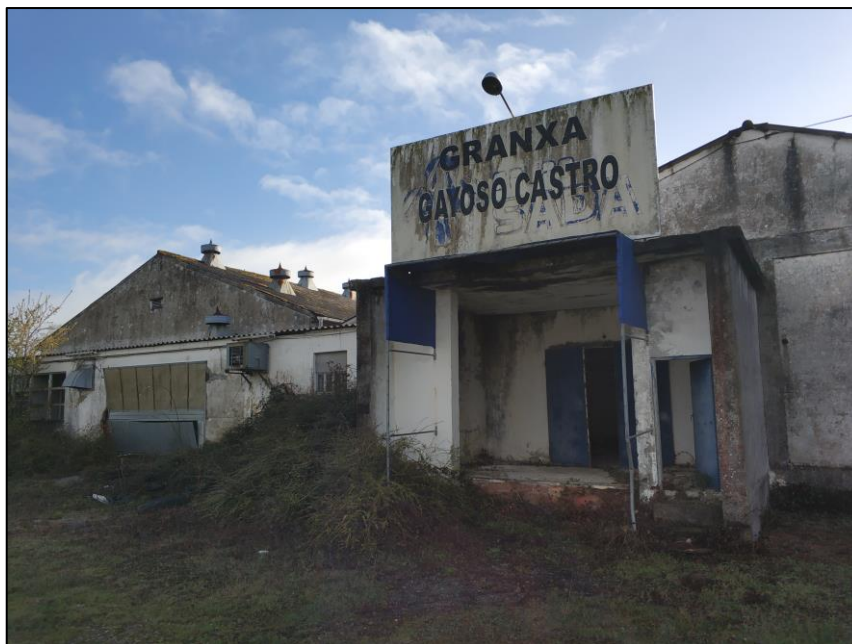
Imaxe 2: Estado actual das instalacións
